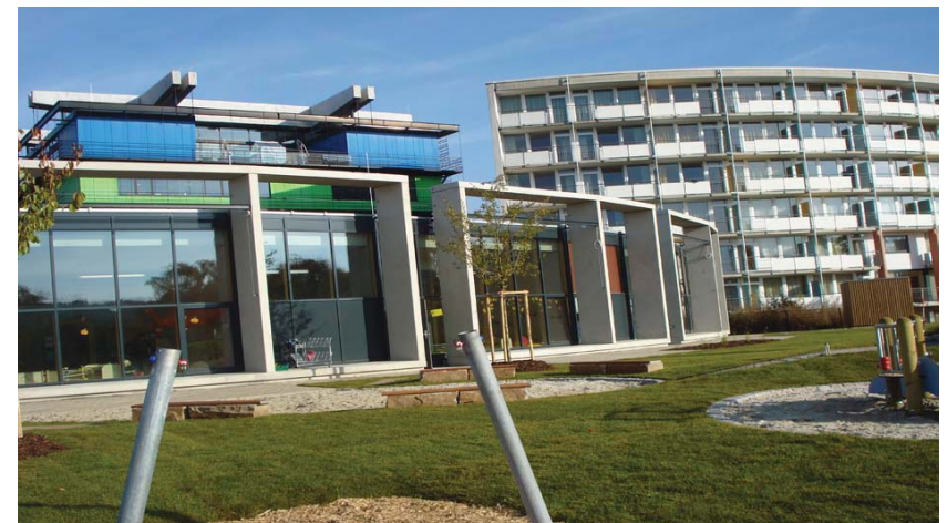
Die neue Kindertagesstätte im Nordcampus, Ansicht. Im Hintergrund XLAB und Gästehaus der Universität © Abteilung Gebäudemanagement der Universität
